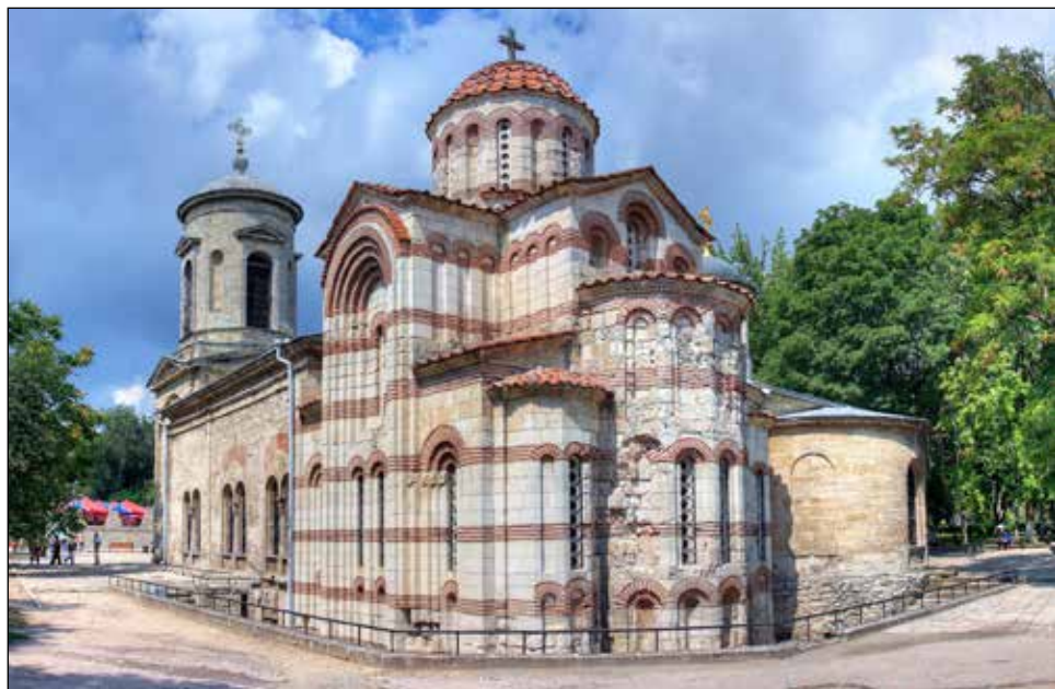
Рис. 54. Церковь Иоанна Предтечи в Керчи (современное состояние)
