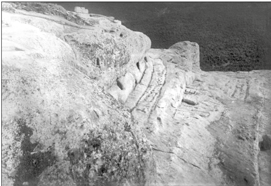
Рис. 33. Плато Эски-Кермен. Верхние марши подъемной дороги после их зачистки в 1930 г. Общий вид с севера
