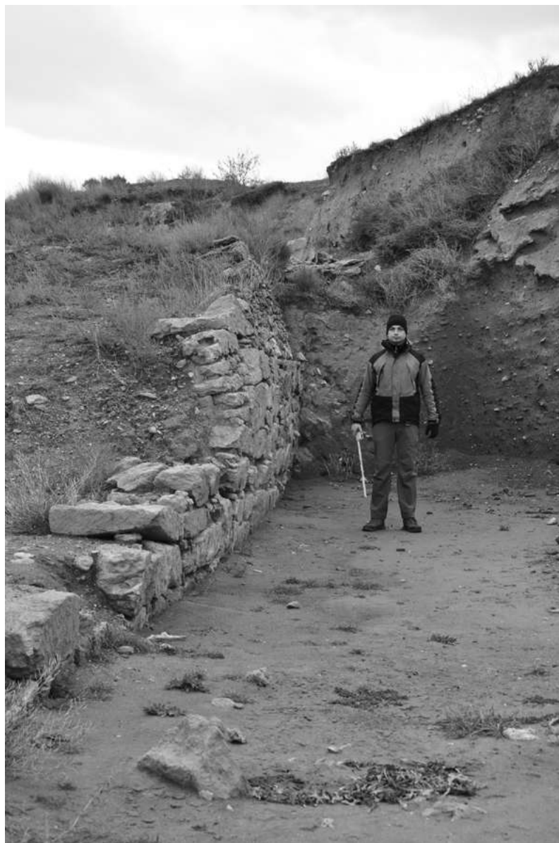
Рис. 1. Наклон городской стены с простиранием 45-50^\circ на ЮВ под углом в 60-65^\circ .
