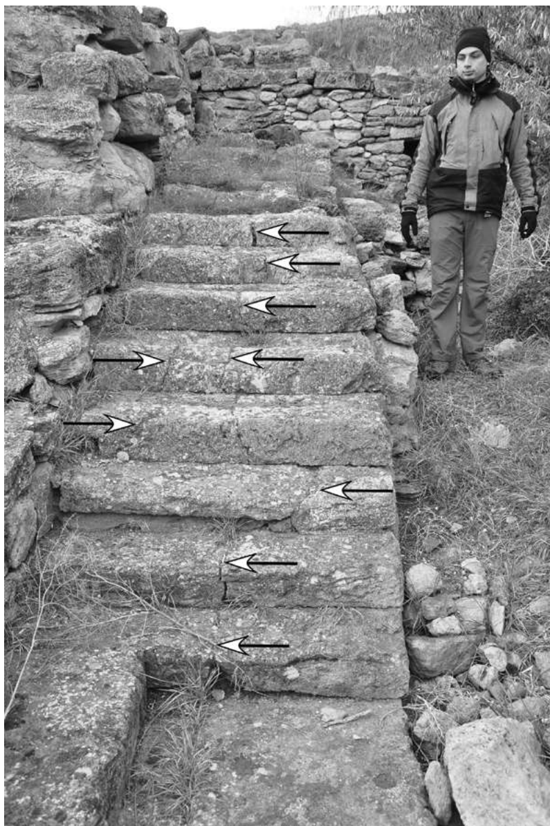
Рис. 4. Сквозные трещины через несколько строительных блоков в одной из лестнице в Нимфее.
