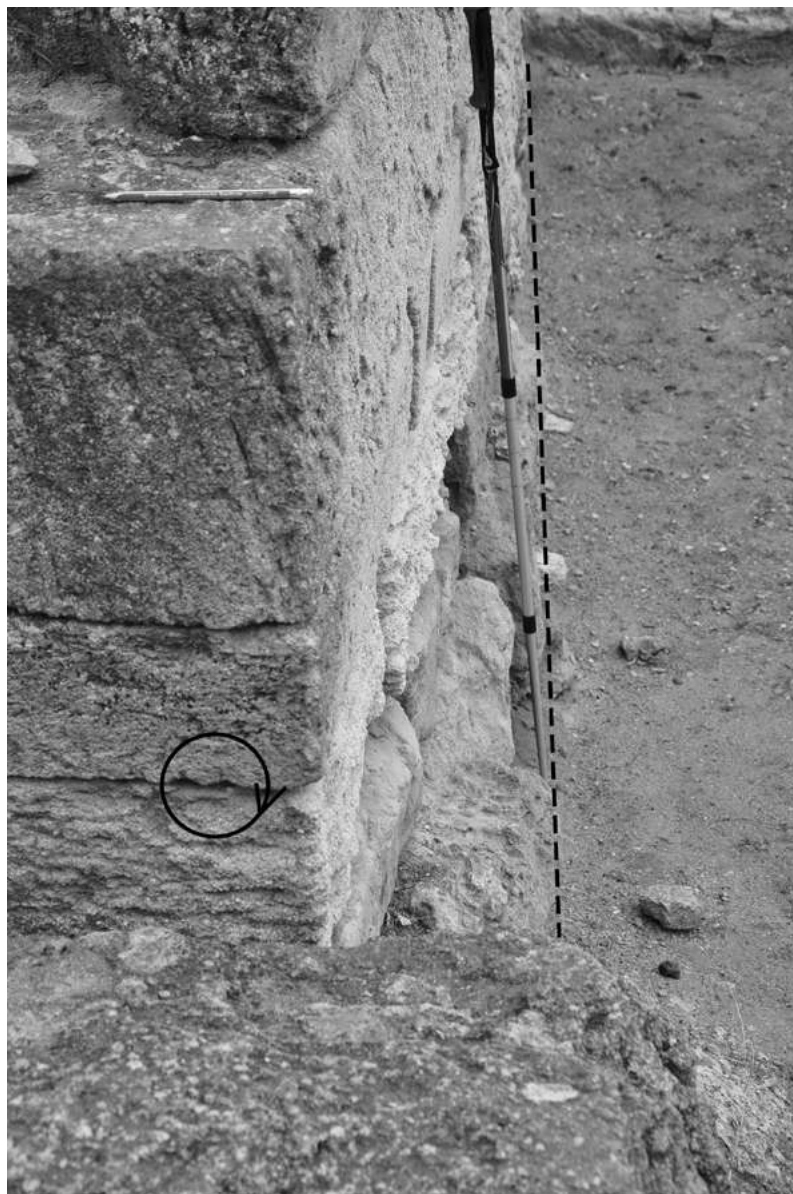
Рис. 3. Поворот верхней части стены по часовой стрелке. Простирание нижнего ряда камней, оставшегося in situ - 85^\circ , повернувшийся фрагмент стены имеет простирание 90^\circ . Западная часть повернутой стены сместилась на север на расстояние в 30 см.
