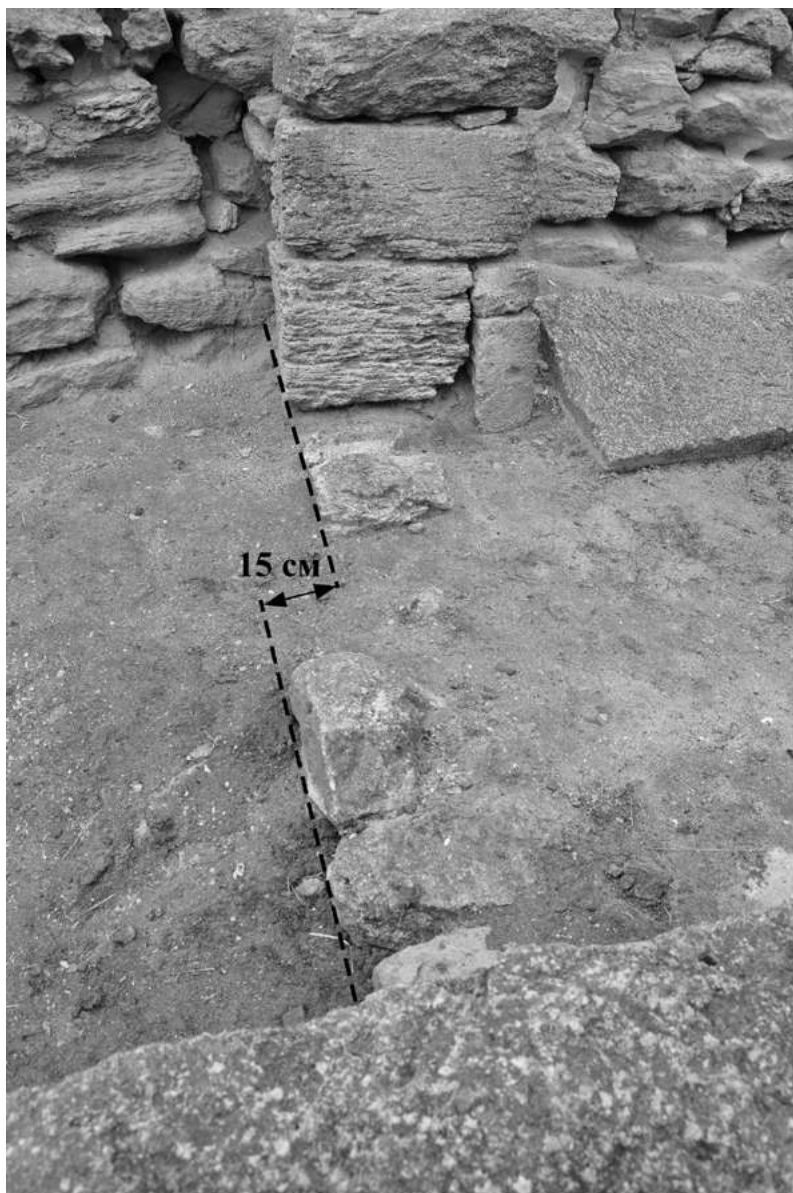
Рис. 2. Разрыв (правый сдвиг) и смещение на 15 см ряда каменной кладки, выполнявшей роль ступени в одном из помещений Нимфея. Простираение ступени 75^\circ .
