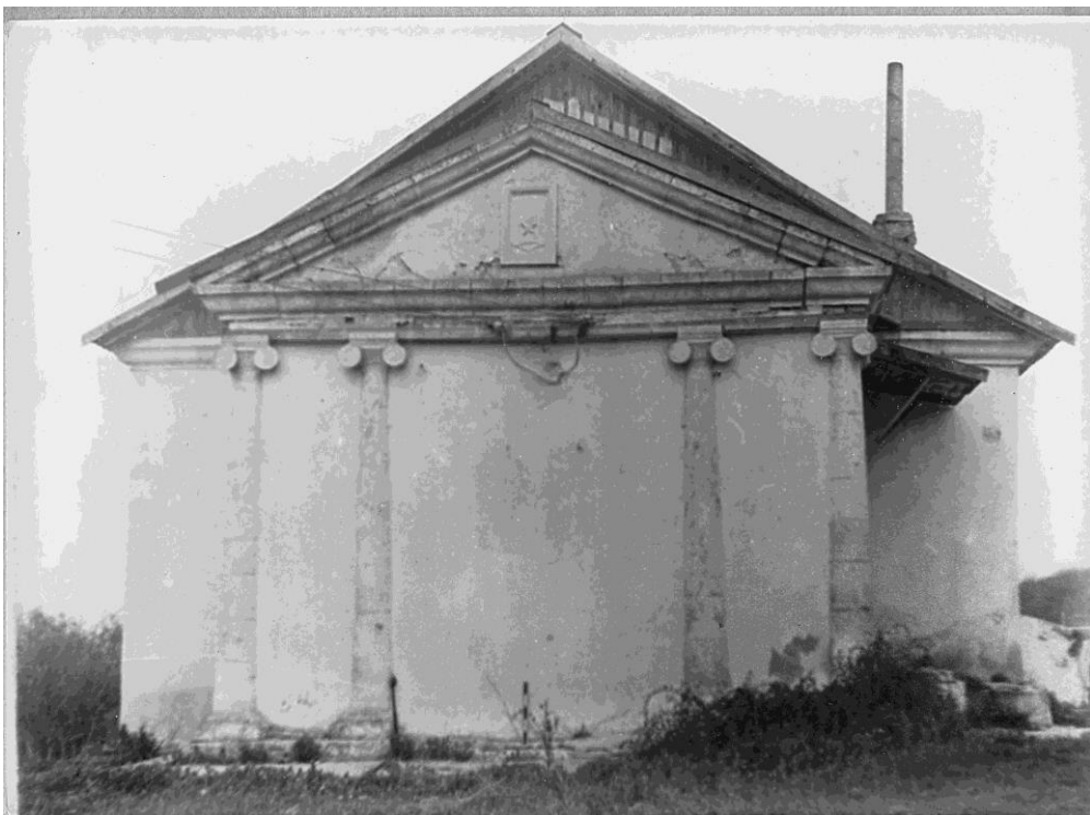
Рис. 4. Константино-Еленинская церковь. Фасад. Фото А. Иванова, 1987 г. [по: 40, рис. 5].
