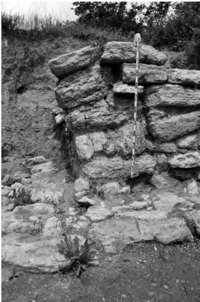
Рис. 2. Сквозная трещина (joint), пробивающая 3 каменных блока насквозь в городской стене (раскоп XXVIII)
